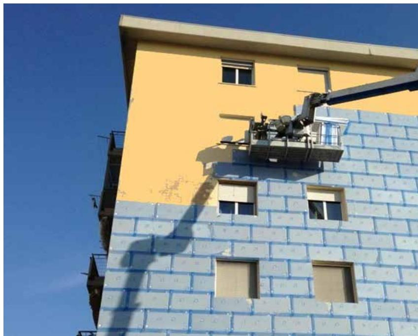
curata valutazione da parte di progettisti, scelta dei materiali, trattamento delle superfici riceventi la pannellatura isolante, l'accostamento degli stessi, schema di posa (no allineati ma sfalsati a “T” o a “W”), incollaggio appropriato, tassellatura adeguata, retinatura e rasatura armata e salva-angoli e finitura. Non ci deve essere aria (camicia d'aria) tra pareti e pannelli isolanti.
